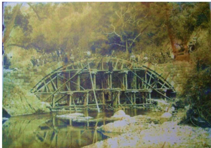
17. 谷川橋(架橋当時の写真)
