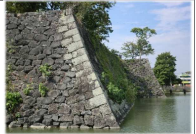
八代産石灰岩で築かれた「八代城の石垣」
