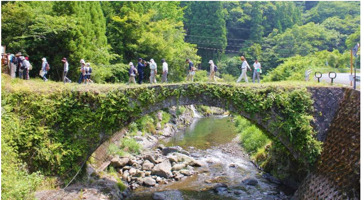
I 5. 鹿路橋(現在も人が渡ることが出来る)
