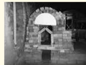
焚き口(ロストル)仮組の様子
