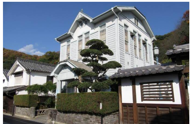
竹原市歴史民俗資料館(昭和4年建築)。近代の建築物も町並みの歩んだ歴史とその景観を継承
