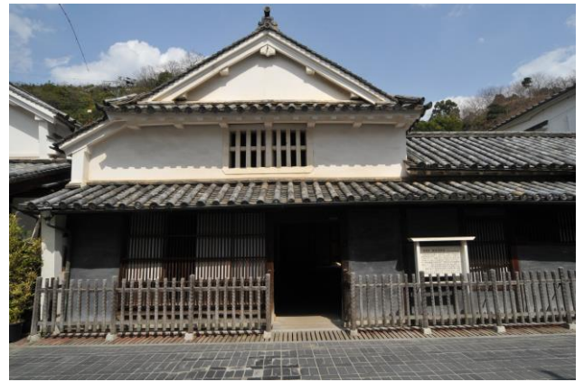
広島県史跡頼惟清旧宅(らいただすがきゅうたく)。入母屋造の主屋と、南(左)に接する切妻造の離れ座敷で構成
