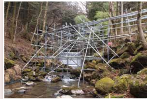
モノレール河川横断状況
