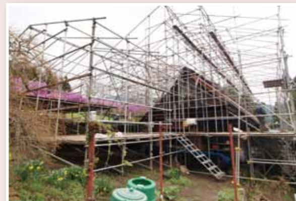
仮設の骨組状況
