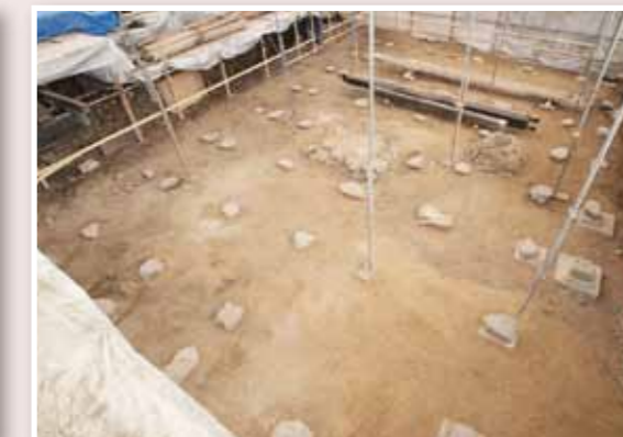
解体終了後状況
