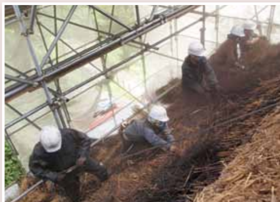
茅葺きの除去作業
