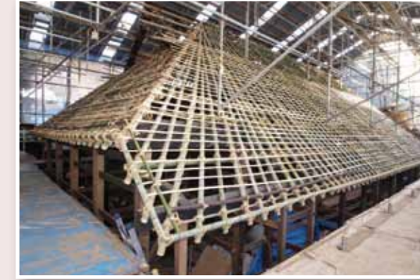
屋根部分骨組の完成
