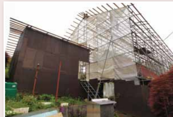
小屋組安全網の設置
