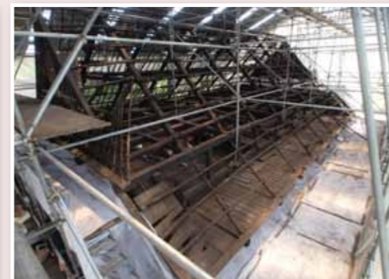
屋根茅葺き取り外し状況
